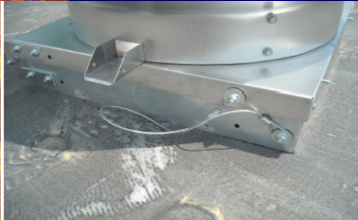
Hinged up-blast fan for Type I hood exhaust
